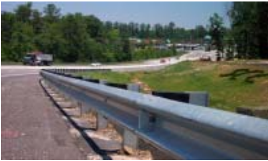
アメリカ guardrail
